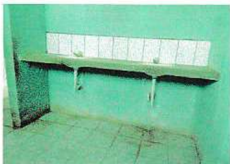
Foto 7: Lavamanos en baño de hombres y mujeres a una altura de 1 m. No apto para niños.
