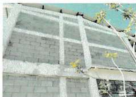
Foto 6: Pared exterior de baños y direccion. Sin pintar ni impermeabilizar.
