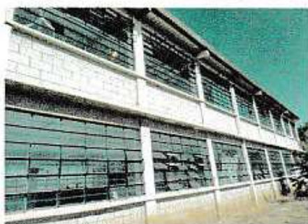
Foto 5: Pared trasera, exterior del edificio. Sin pintar ni impermeabilizar.
