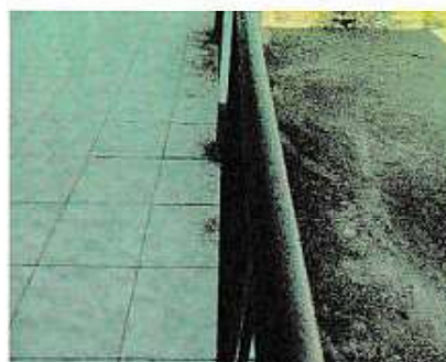
Foto 12: Barandael con muestras de oxidación. Vista de este a oeste.
